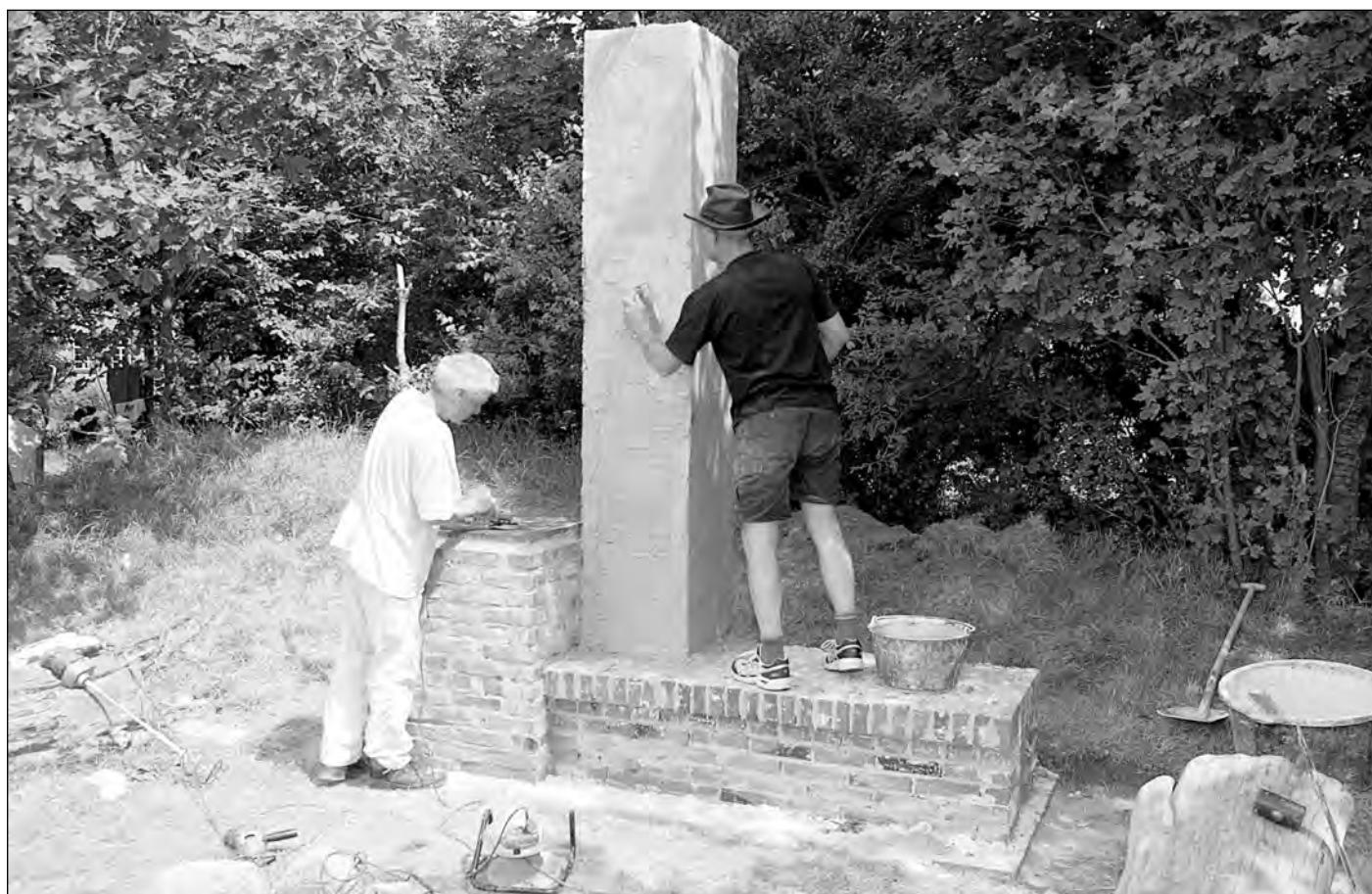
Leif Ellegaard (t. v.) og Finn Kristensen er i gang med at pudse ovnen og lægger dermed sidste hånd på eksperimentet, det seneste par dage har været i gang på sommerhøjskolen på Ladelund Ungdomsskole. (Fotos:Lars Salomonsen)
